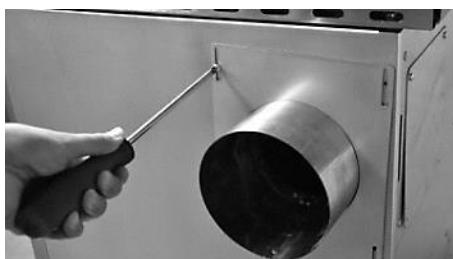
montirajte produžetak izvoda dimnjaka na mjestu gdje se nalazi priključak za dimnjak (bočno ili otraga) te podesite visinu i dobro zategnite
